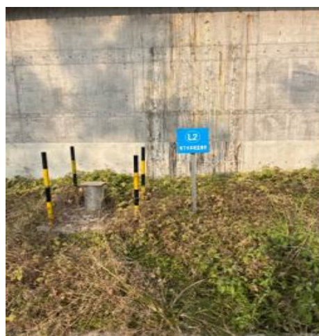
2#地下水检测井
